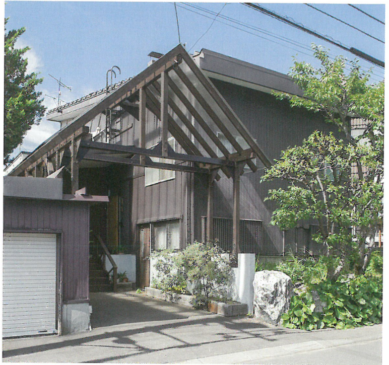
閑静な住宅街にある菊地宅。エントランスに日光をとおす屋根をかけ、雪対策と明るさに配慮。玄関は階段を上った右奥に。
