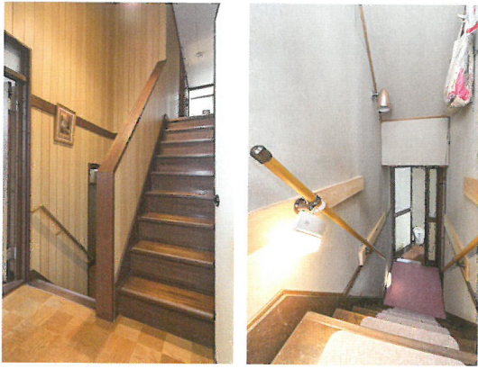
右／納戸になっている半地下に続く階段。人感センサーライトが足元を照らす。 左／リビングから書斎のある中2階へ続く階段には、壁に手すりを設置。
