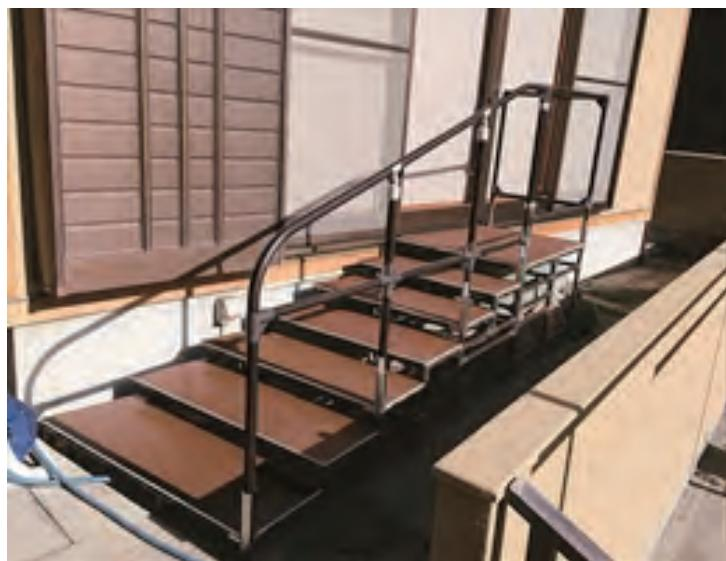
玄関の段差解消が困難なので大きな窓から出入りできる階段の設置例。必要が無くなった際の撤去も容易だ。階段部分の代わりにアルミ板などを渡してスロープにもできる
