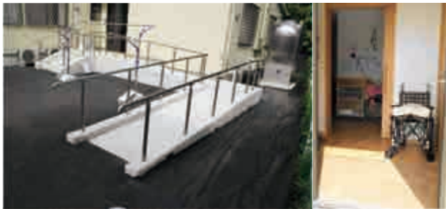
スロープを設置し、段差を解消した玄関回りなど、車いすでの出入りにもしっかり配慮されています。
