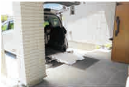
車いす用の車両と外玄関の高さを合わせました。こうした工夫を含め、この新築では本誌「ふれあい」の過去の実例を随所に役立てていただいたそうです。
