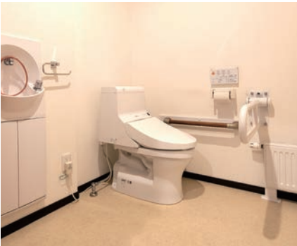
リングそばの多機能トイレ。上体が前に倒れたときに支えとなるよう、便器の前面に可動式手すりを設置している。
