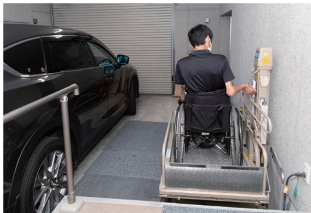
信寿さんの愛車は、玄関ホールから出入りできるビルトインガレージに。車いす用電動昇降機を使って自力で移動する信寿さん。
