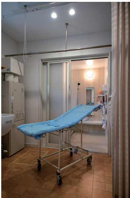
洗面・脱衣室もスペースを十分確保し、中央部に床暖房を設置。ストレッチャーを使用する優さんの入浴介助に配慮し、ユニットバスは大型（1.25坪）に。
